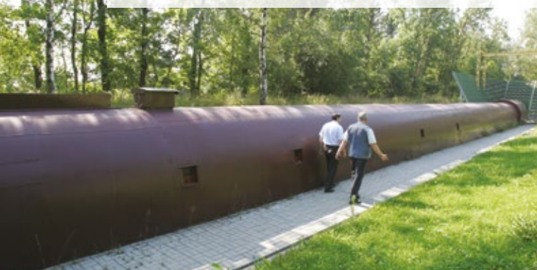
Sztolnia doświadczalna (44m) do badań bezpieczeństwa materiałów wybuchowych wobec pyłu węglowego i metanu Surface adit (44m) for explosives' testing (coal dust and methane)
