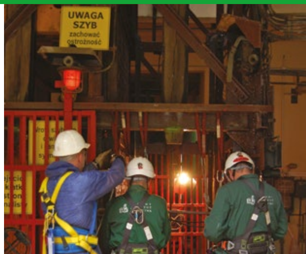
Badanie stanu obudowy szybu technikami dostępu linowego Inspection of the condition of the shaft lining using rope access technology
