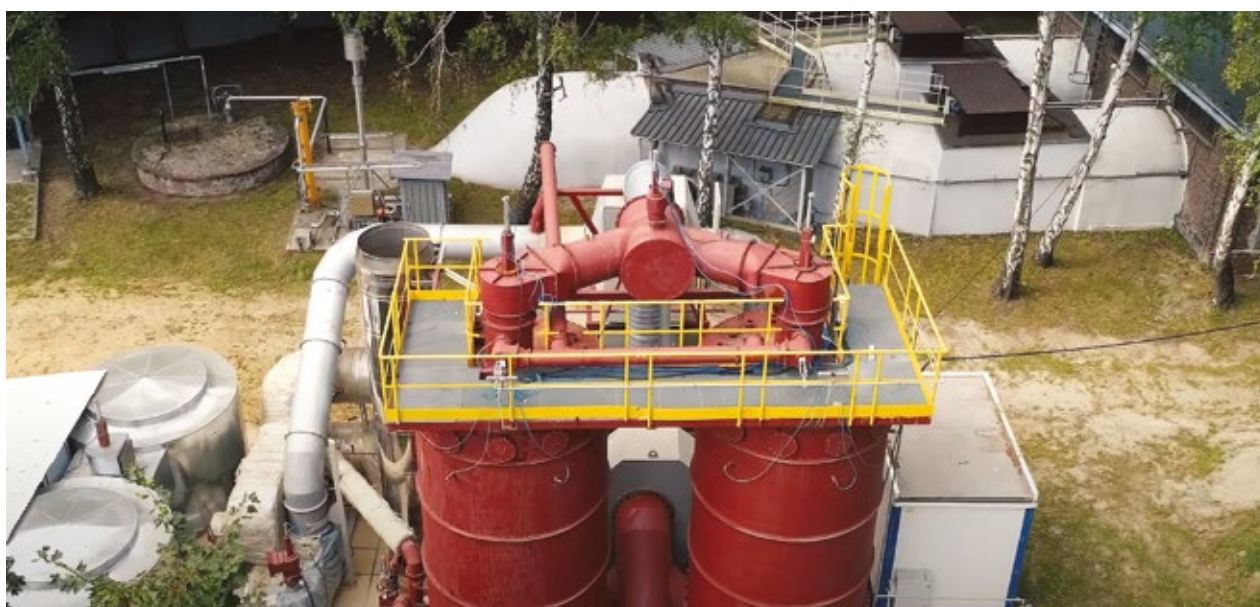
Instalacja do odzysku metanu z powietrza wentylacyjnego zabudowana przy szybie wentylacyjnym KD „Barbara” Installation for the utilization of methane from ventilation air built at the EM Barbara ventilation shaft
